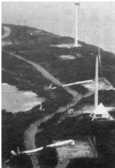
宮古島狩俣の風車群の台風被害状況
